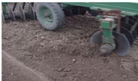
Escarificado del suelo a estabilizar
