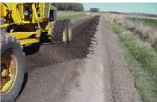
Perfilado y nivelación
