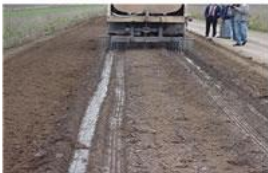
Regado del suelo hasta humedad óptima con solución de agua y Sika Suelos 21.
