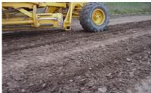
Escarificado del suelo a estabilizar
