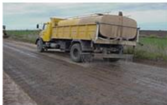
Regado superficial final con la solución de Sika Suelos 21
