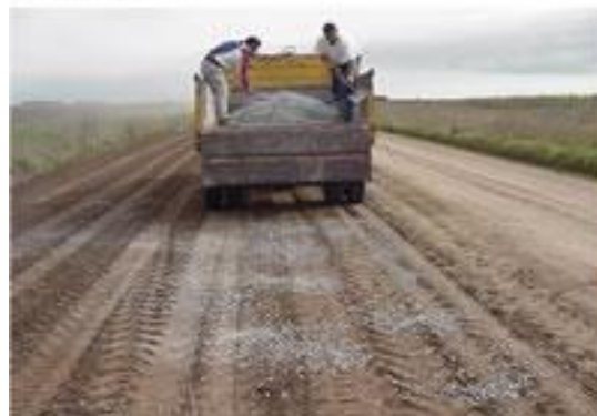
Colocación de piedra partida como anclaje superficial y compactación final.
